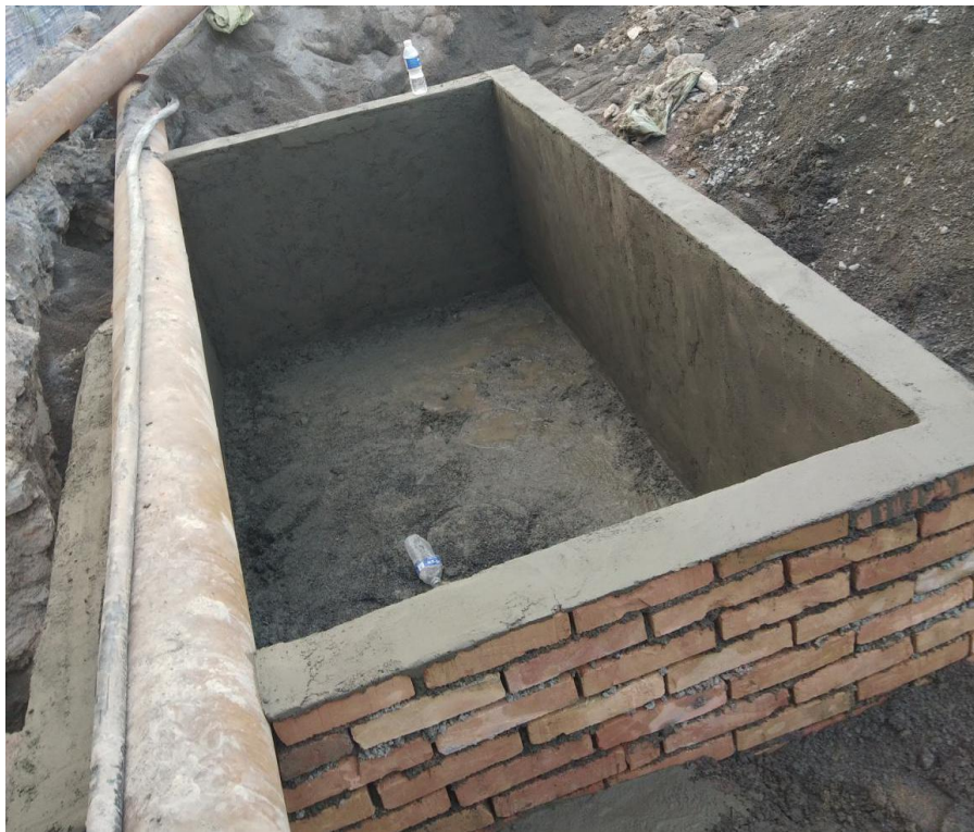
初期雨水收集池
