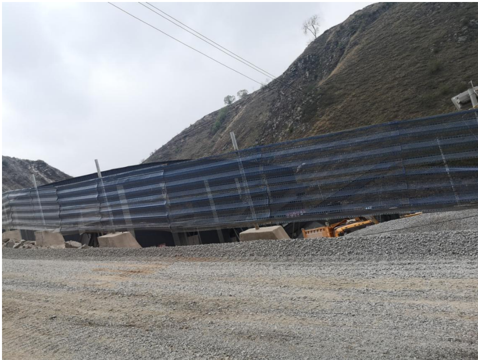
厂界西面防风抑尘网（厂界西面运输道路地势高于生产区约4米）
