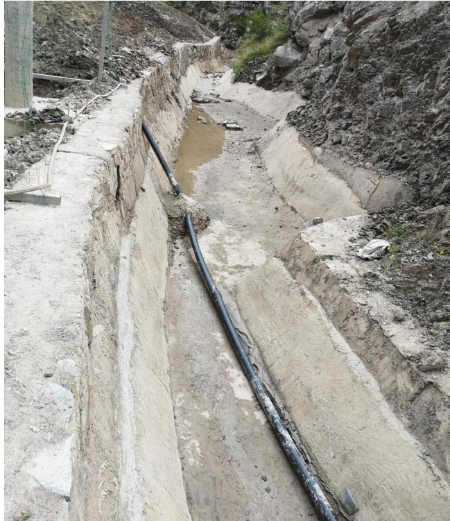
厂界西侧排洪沟
