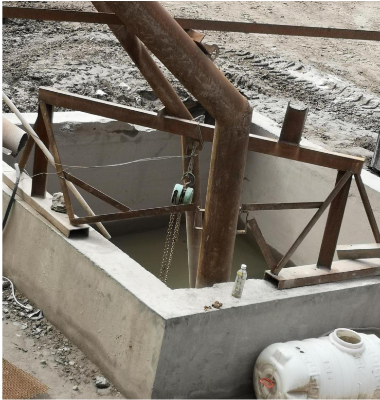
生产废水收集池
